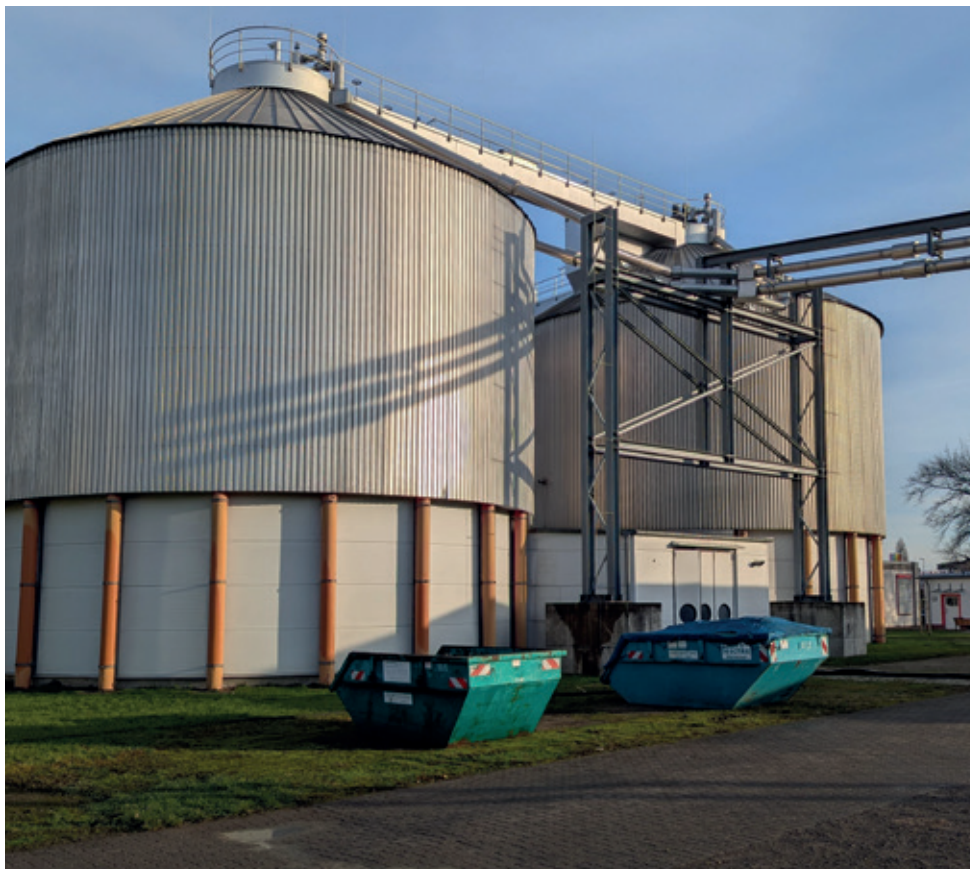
Faulbehälter, die zur Remobilisierung eingesetzt wurden im Großmaßstab am Standort Braunschweig (links) und am Standort Gifhorn (rechts). © P-Net
